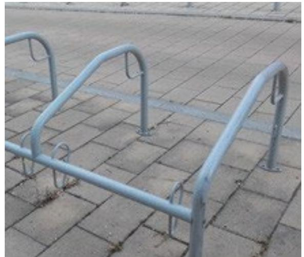
Foto 4: Bügel mit Vorderradhalterung ©eNu
